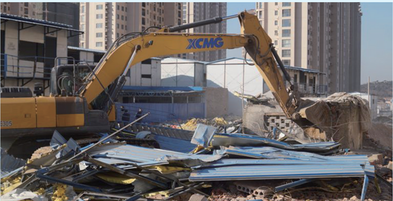
李沧集中拆除20余处超期临建。
